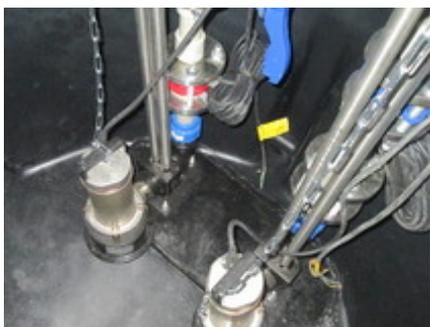
[Дренажная насосная станция с насосом KSB Ama-Porter 5 00 NE производительностью 15м3/час. напором 5 м](#)
