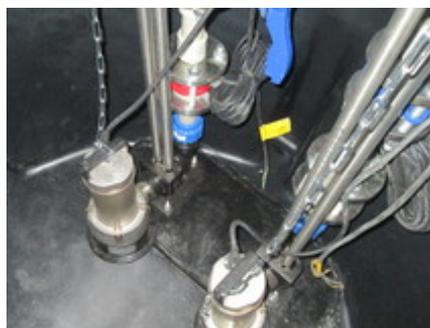
[Дренажная насосная станция с насосом KSB Ama-Porter 502 NE производительностью 18м3/час. напором 7 м](#)
