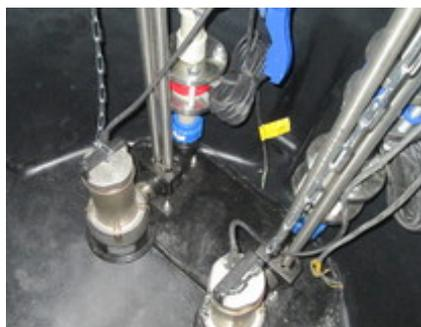
[Дренажная насосная станция с насосом KSB Ama-Porter 5 01 NE производительностью 18м3/час. напором 5.5 м](#)
