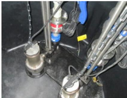
[Канализационная насосная станция с насосом KSB Ama-Porter 5 01 NE производительностью 18м<sup>3</sup>/час, напором 5.5 м](#)
