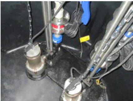
[Канализационная насосная станция с насосом KSB Ama-Porter 5 00 NE производительностью 15м<sup>3</sup>/час, напором 5 м](#)
