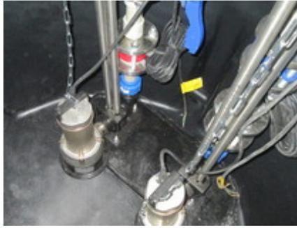
[Канализационная насосная станция с насосом DAB FEKA VS 1200 M-NA производительностью 10м<sup>3</sup>/час, напором 12 м](#)
