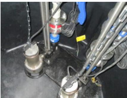
[Канализационная насосная станция с насосом KSB Ama-Porter 502 NE производительностью 18м<sup>3</sup>/час, напором 7 м](#)
