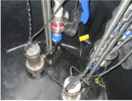
[Канализационная насосная станция с насосом DAB FEKA VS 1000 M-NA](#)
