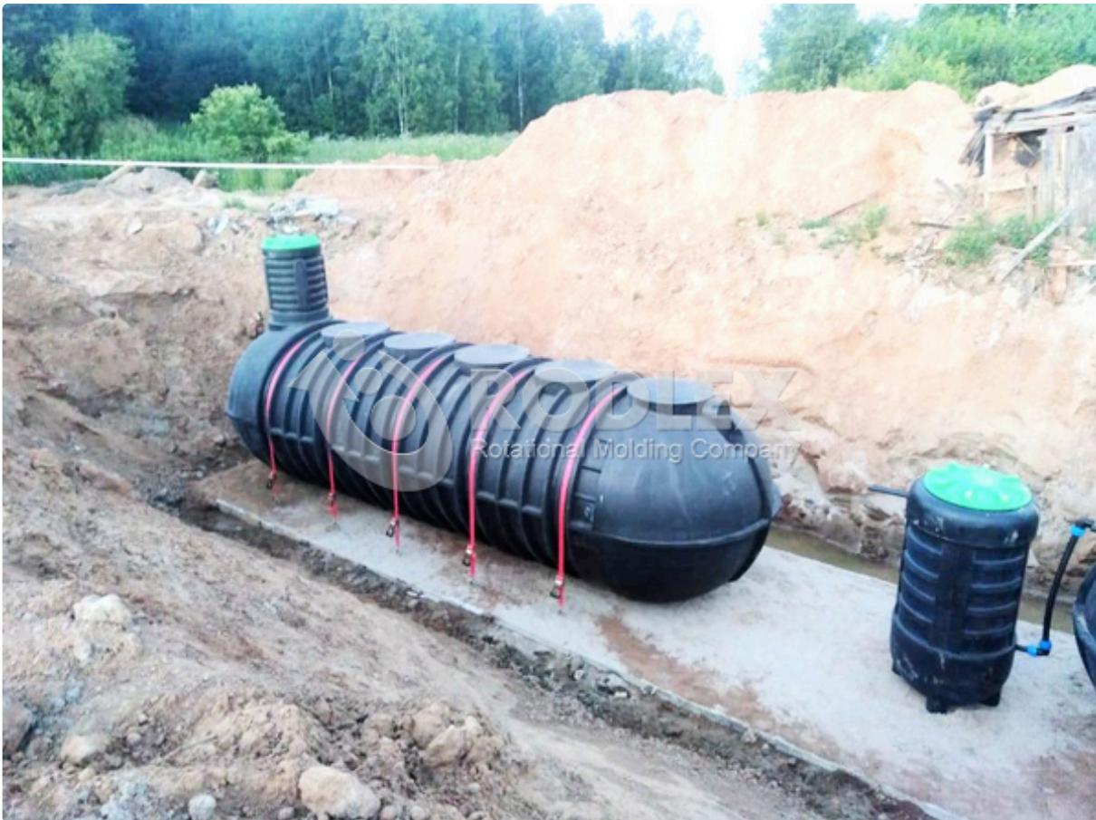
Самотечное очистное сооружение для очистки сточных вод групп домов производительностью 10м<sup>3</sup> в сутки с полями фильтрации BioBox Aero MEGA
